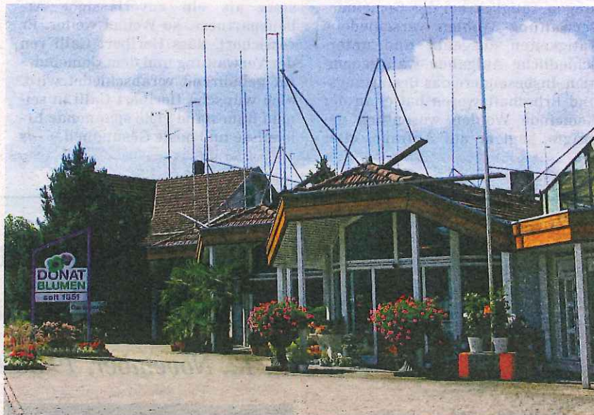
Der «Stangensalat» wird bald etwas Stabilerem weichen müssen: Der Baustart des Wohnparks «Steindler» erfolgt im Herbst 2015.
